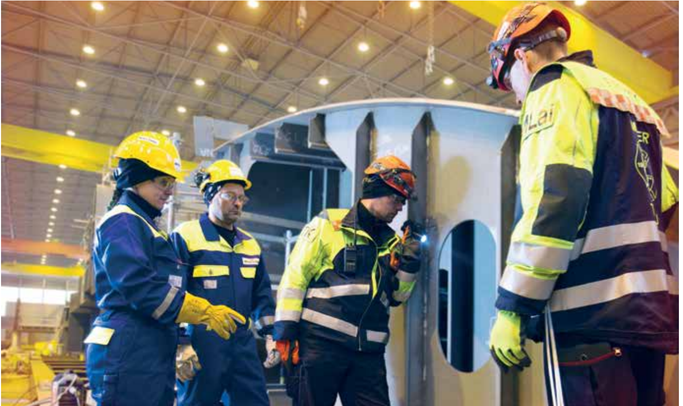
Palotarkastukset sekä halleissa että rakenteilla olevassa laivassa ovat telakan palokunnan arkea.
